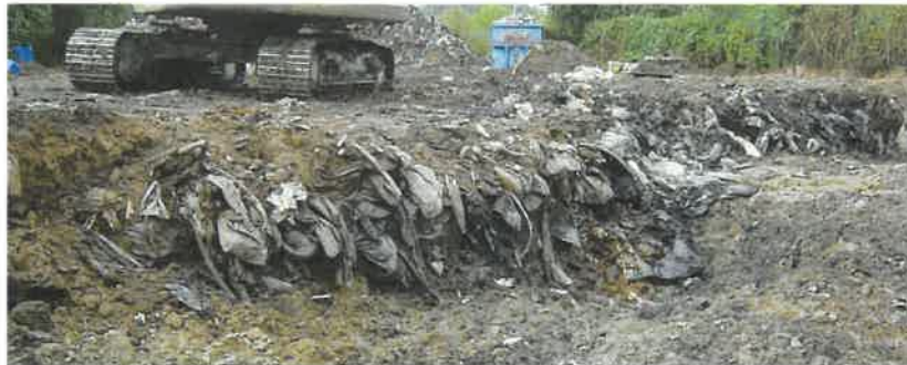
Figure 8 : paroi de fouille nord de la zone B
